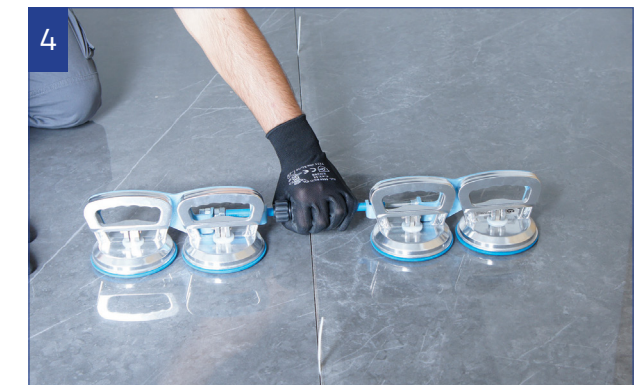
Durante la posa a parete i piedini d'appoggio del KERA-LIFT eviteranno danni alla lastra. During the fixing on the wall the support feet of the KERA-LIFT will avoid damage to the tile.
