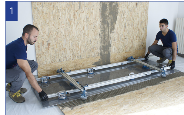
Posa a terra con telaio di movimentazione KERA-LIFT. Tiling the floor with the handling frame KERA-LIFT
