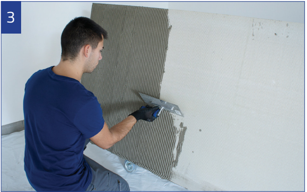
Stesura della colla con il KIT-CARRELLO. Applying the thinset with the CARRIAGE KIT.
